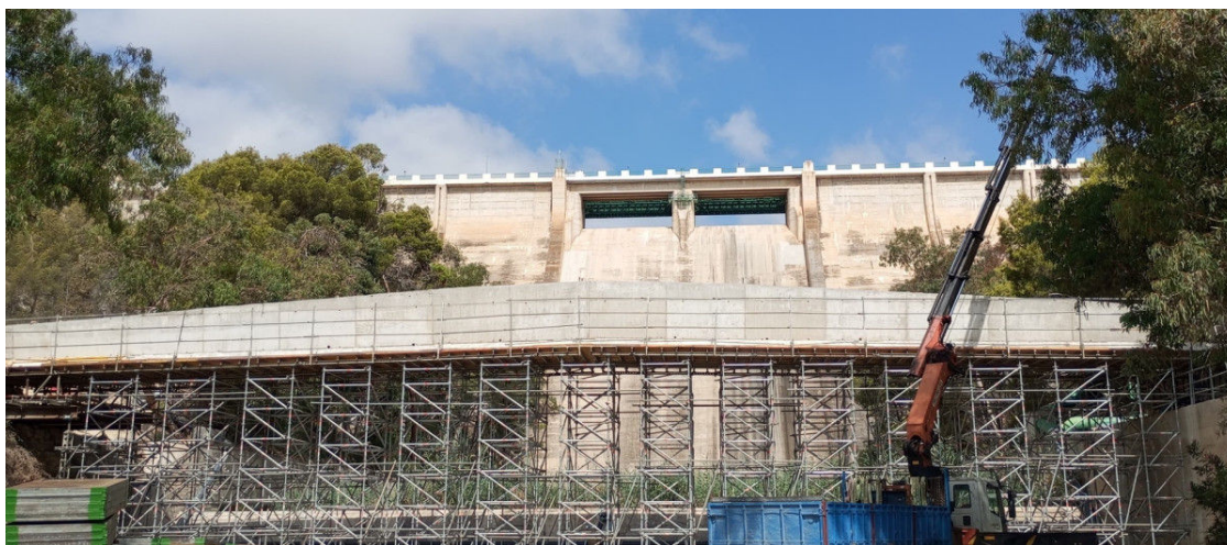
Obras en el embalse de Amadorio (Alicante)CHJ
